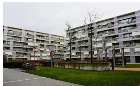
Lodenareal 项目外观
